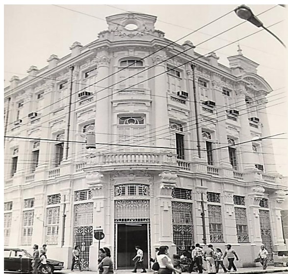
Figura 3 – Vista de frente da Antiga Sede localizada no Centro da Cidade
